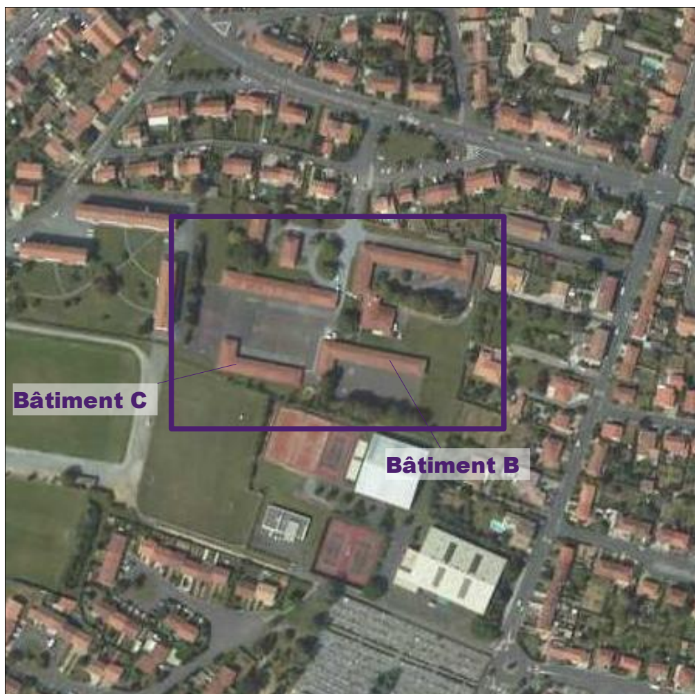
Illustration 1: localisation du groupe scolaire Pasteur et des bâtiments étudiés (source : Google Maps)
