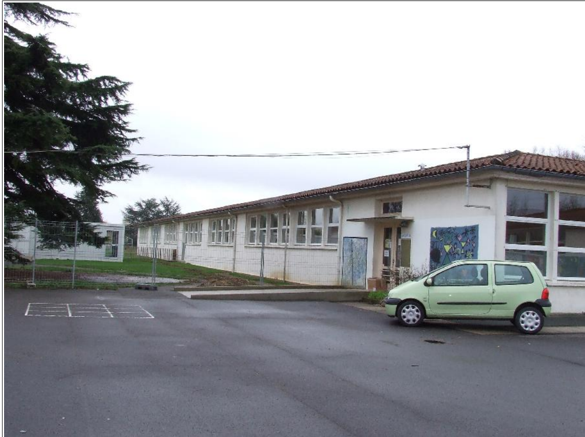
Illustration 4 : vue extérieure du bâtiment B
