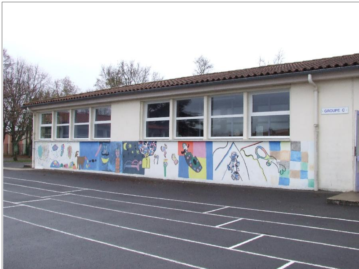
Illustration 5 : vue extérieure du bâtiment C
