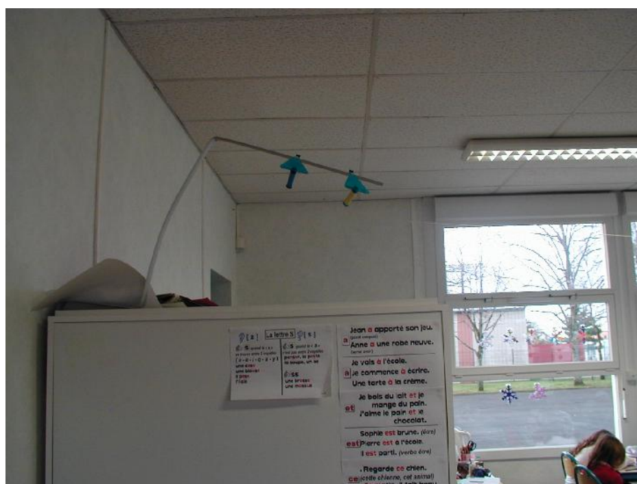
Illustration 11 : échantillonneurs d'air intérieur installés dans la salle B2
