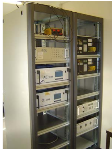
Illustration 1: vue intérieure de la station "COGNAC"
